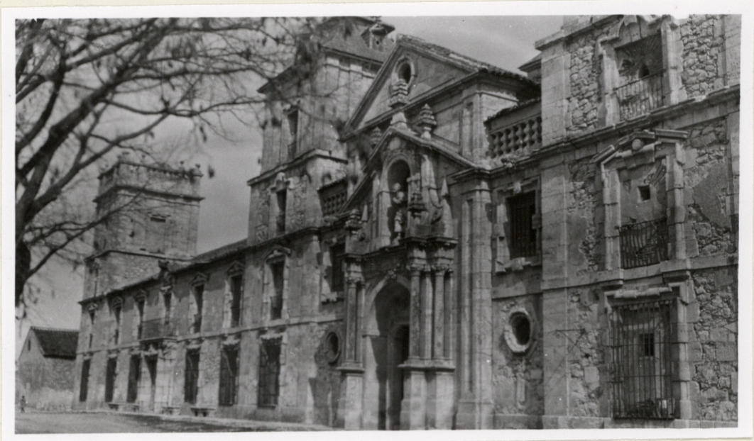
15.- Nuevo Baztan - Vista general de la fachada principal
